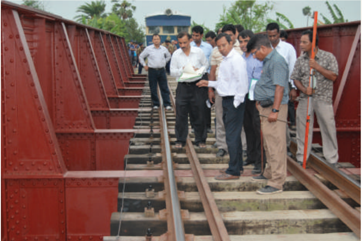
সরকারী রেলপথ পরিদর্শক কর্তৃক কাঁকনহাট ও সিতলাই স্টেশনের মধ্যবর্তী সেতু নং-৮৭ পরিদর্শন
